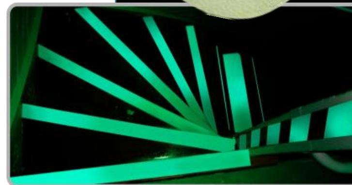
Фотолюминесцентные материалы Jessup® изготавливаются с применением безопасных природных люминофоров, которые накапливают энергию от любого источника освещения и длительное время светятся в темноте.
